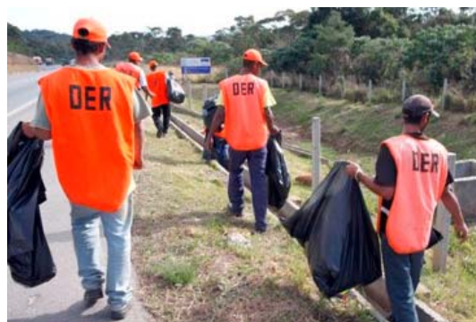
Internos da PIC trabalhando na limpeza e conservação de rodovias no Município.
